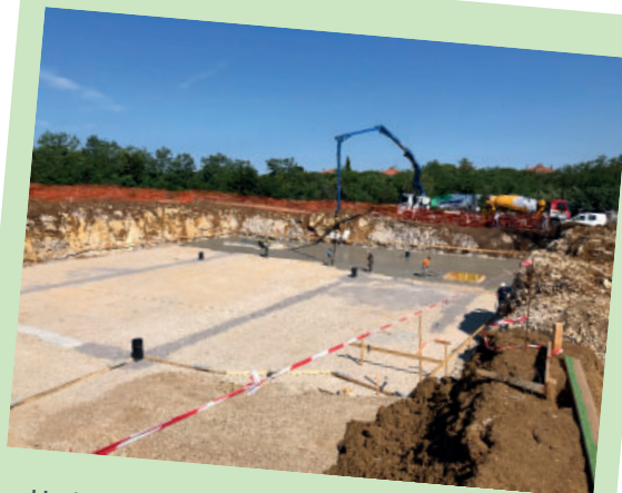
2 Underlayment concrete under the basement Podložni sloj betona pod kletno ploščo
