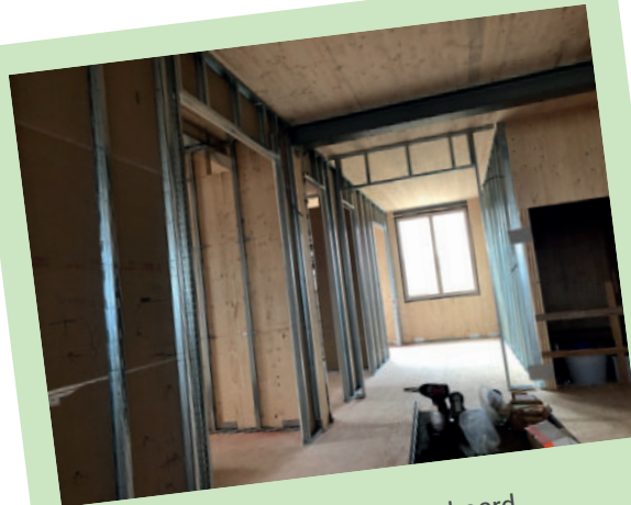
Installation of gypsum board partition walls Montaža predelnih sten iz mavcnokartonskih plošč
