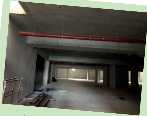
Sewer installation in the garage Montaža kanalizacije v garaži
