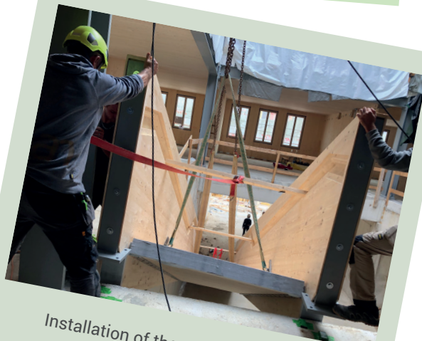
Installation of the main staircase (1) Montaža glavnega stopnišča (1)
