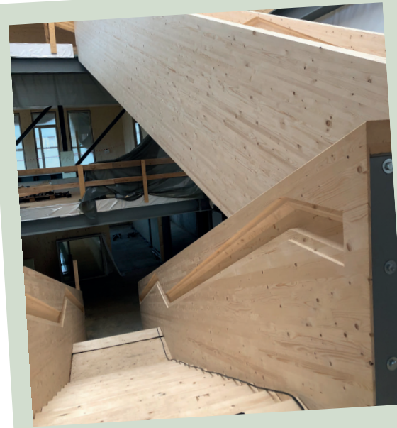
Installation of the main staircase (4) Montaža glavnega stopnišča (4)
