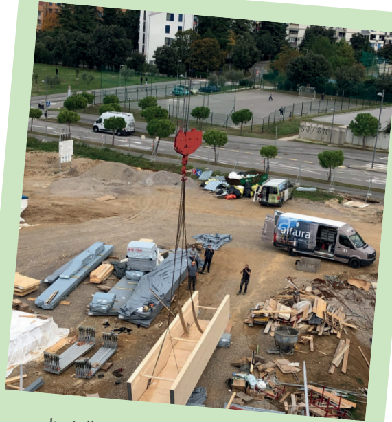
Installation of the main staircase (1) Montaža glavnega stopnišča (1)
