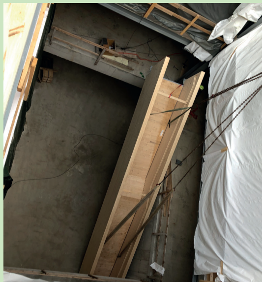
Installation of the main staircase (2) Montaža glavnega stopnišča (2)
