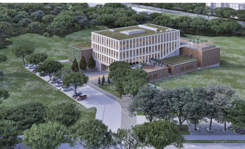
1.400 m 2 walkable green roof terraces will also serve as an open-air test site. Image: InnoRenew CoE / Inštitut bo imel 1.400 m 2 zatravljenih pohodnih strešnih teras, ki bodo uporabljene tudi za testni poligon na prostem. Foto: InnoRenew CoE
